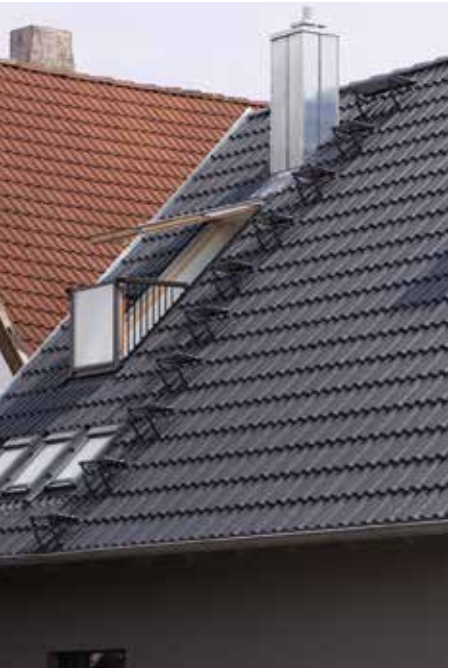
Nosná škridla s držiakom stúpacej plošiny
